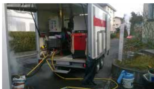
Réparation de canalisations
