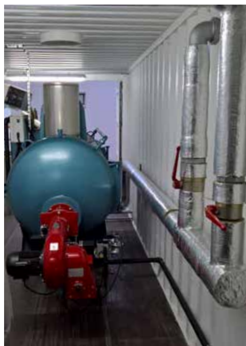
Chaudière + Groupe de Production d'eau chaude (pour eau de malaxage)
