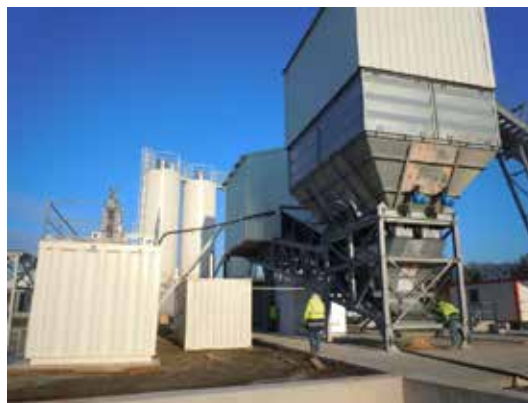
Container équipé d'un générateur de vapeur avec un groupe de production d'eau chaude
