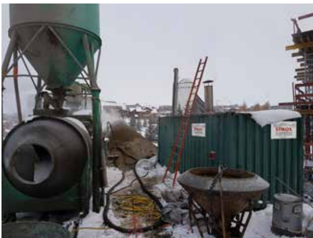
Centrale louée pour travaux en station de montagne : construction de bâtiments
